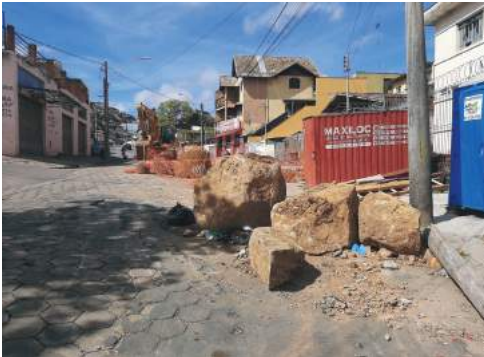
Sofrimento prolongado: a cada etapa da canalização, moradores são afetados
