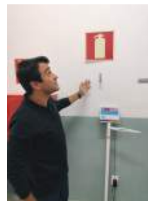
O PSF não tem extintores
