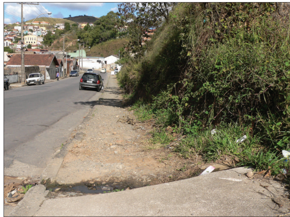
3º Mundo: Trecho sem calçada e com esgoto a céu aberto, no Boa Esperança
